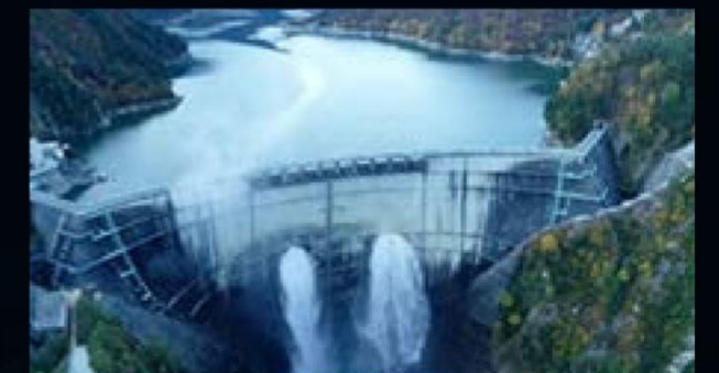
Inspekcja i konserwacja zapory należącej do Kansai Electric Power w Japonii
