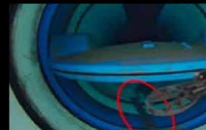
Inspekcje zaworów rurociągów
