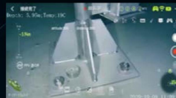
Inspekcja strukturalna i jakości wody w elektrowniach jądrowych w Japonii
