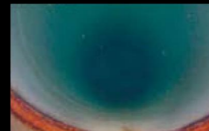
Inspekcje rurociągów zasilających
