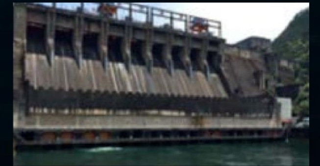
Inspekcja chińskiej Elektrowni Wodnej w Sinciang
