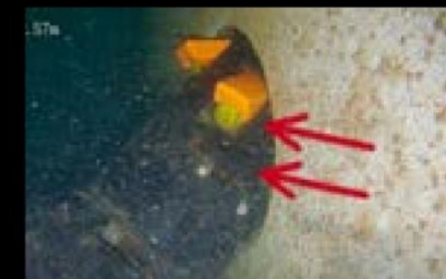
Inspekcje ograniczników zagięć
