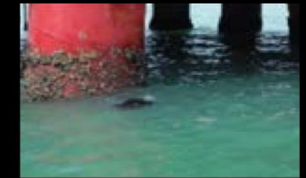
Inspekcje infrastruktury morskiej
