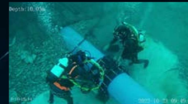
Konserwacja i monitorowanie uszkodzeń rurociągów podwodnych w Grecji
